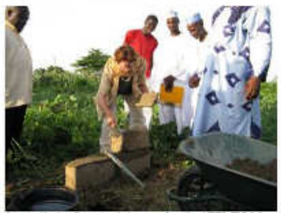
Symbolische Grundsteinlegung für die AFEMDI-Mauer in Maroua
